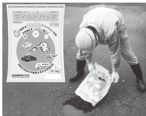
「マイルドパッチ」は、水で固まる袋詰めのアスファルト混合物です。アスファルト舗装に空いた穴の補修や、屋外の段差解消などDIYで行えます。
