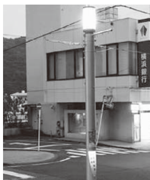
湯河原駅前通り明店街では、既設片流アーケードを撤去して街路灯を新設しました。商店街名を柱に表示してLED光源による投光照明です。近い将来、電線地中化されます
