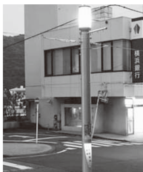
湯河原駅前駅前明商店街では、既設片流アーケードを撤去して街路灯を新設しました。商店街名を柱に表示してLED光源による投光照明です。近い将来、電線地中化されます
