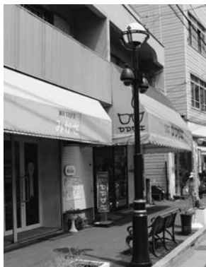
逗子市池田通り商店街では、電線地中化に伴う街路灯を新しくしました。安心安全のまちづくりで防犯カメラを街路灯に共架しています
