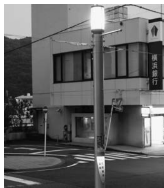
湯河原駅前駅前明商店街では、既設片流アーケードを撤去して街路灯を新設しました。商店街名を柱に表示してLED光源による投光照明です。近い将来、電線地中化されます
