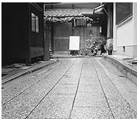
「御影石風ベアコートW」は打ち水などによる路面温度の上昇抑制効果と、美しい仕上がりを併せ持つ景観舗装です
