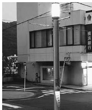
湯河原駅前通り明店街では、既設片流アーケードを撤去して街路灯を新設しました。商店街名を柱に表示してLED光源による投光照明です。近い将来、電線地中化されます
